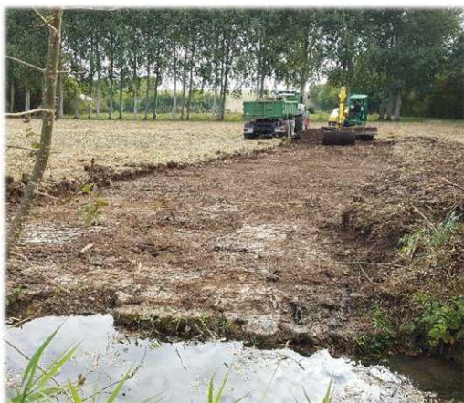
Effacement partiel des talus - 2017
