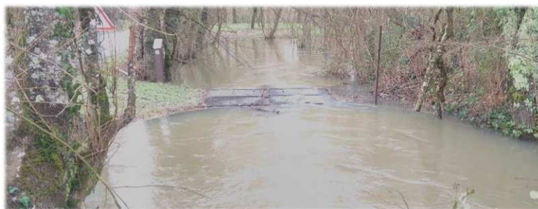
Pièges recouverts par les eaux le 23 janvier 2018
