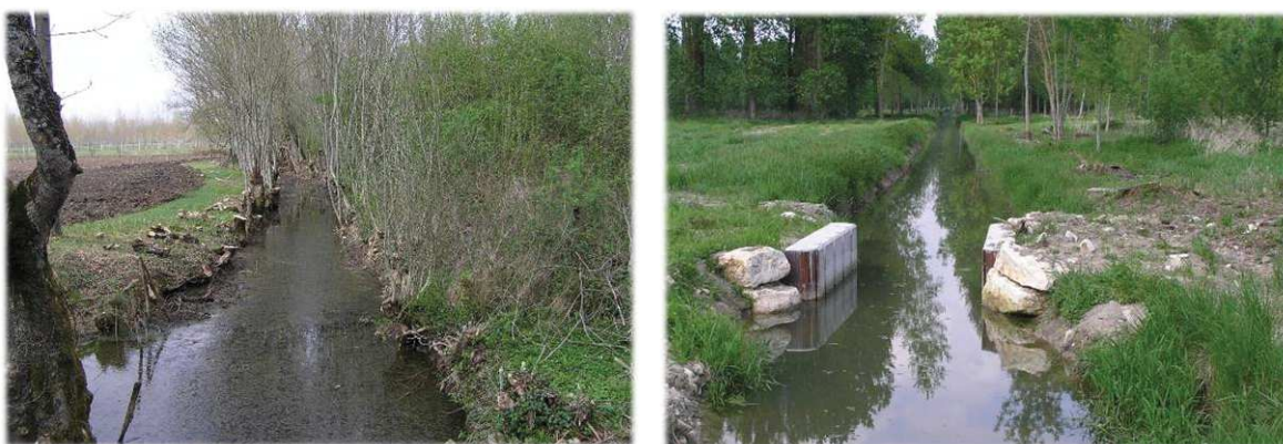
Entretien des fossés et mise en place des structures pour les ouvrages hydrauliques - 2005
