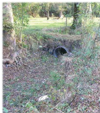
Buse sur fossé principal - 2009
