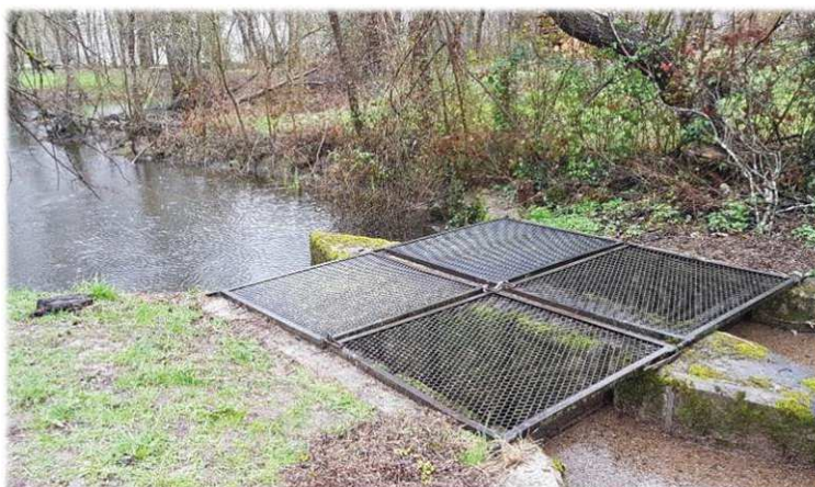
Pièges installés sur l'ouvrage hydraulique de St Groux
